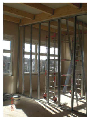
Trockenbau 1. OG / Zwischenwände
