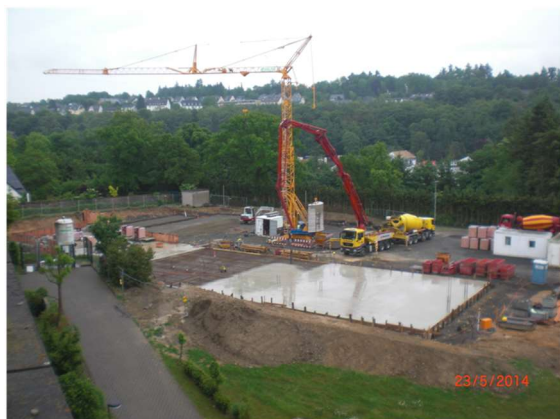
Die Bodenplatte entsteht
