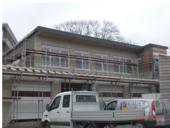
Fenster und Türen sind eingebaut
