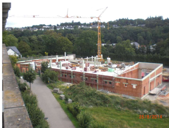
Der Rohbau beginnt
